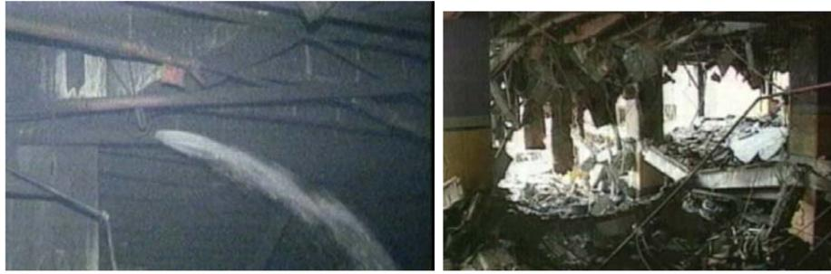
Tuberías rotas con escape de agua y daño estructural que produjo agujeros de hasta tres pisos de profundidad
